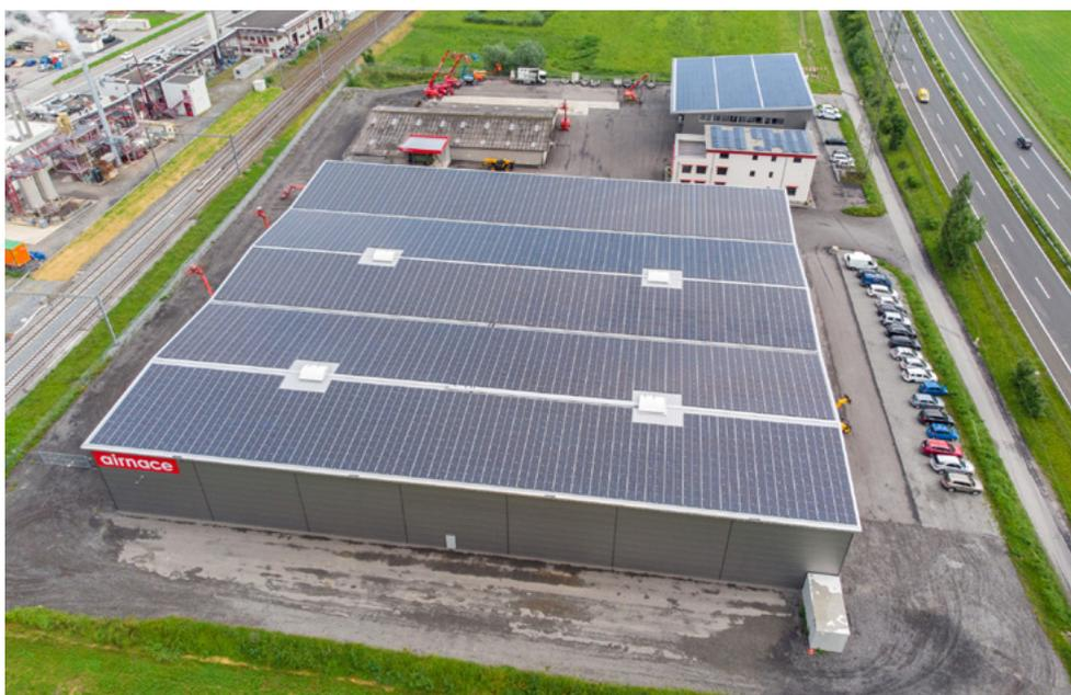
La centrale mégawatt sur la toiture de la nouvelle halle d'Airnace produit 1,3 million de kWh avec 6500 mètres carrés de panneaux photovoltaïques.
