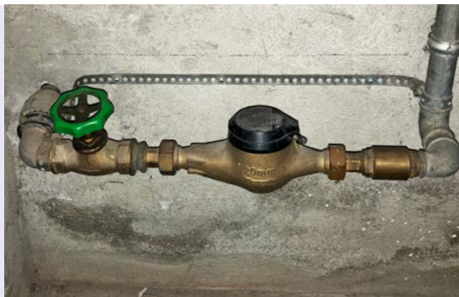
Remplacement de compteur
